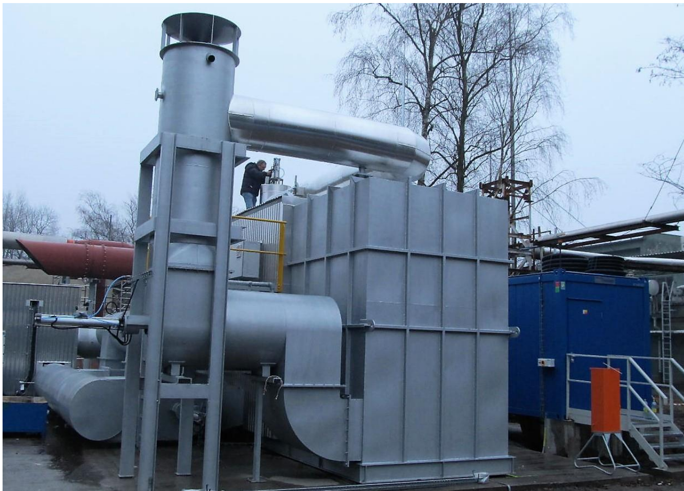
Obrázek 1 Montáž RCO jednotky.
